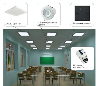
Освещение класса осуществляется диммируемыми светильниками ДВО12 Opal RD. Светильники объединены в группы с датчиками движения, комбинированными датчиками. Обеспечивается 500 лк на поверхности рабочих столов с высокой равномерностью. Аварийное освещение осуществляется отдельными светильниками (например, ДВО92). Диммирование светильников производится автоматически или с помощью кнопочной панели.
